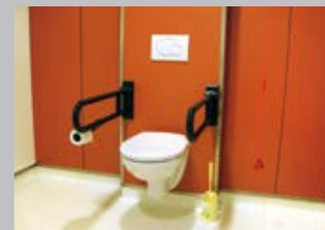
✓ Toilette adaptée disposant de 2 aires de transfert
