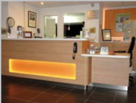
✗ Tablette surbaissée trop peu profonde
