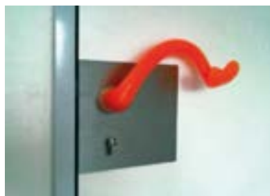
✓ Poignée contrastée et actionnable poing fermé
