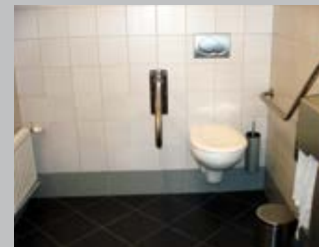
✓ Toilette adaptée disposant d'une aire de transfert face à la porte
