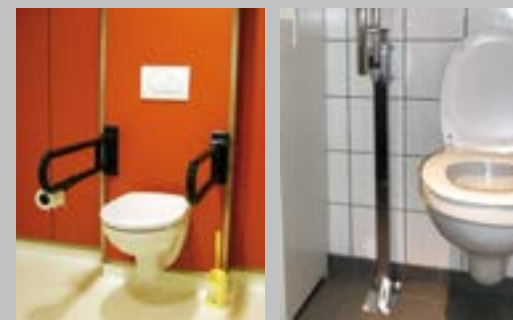
✗ Sabot de fixation dans la zone de transfert
