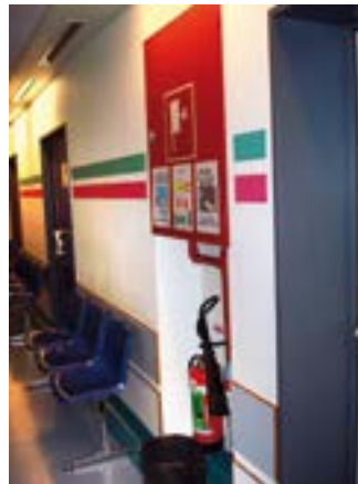
✓ Extincteur placé dans une niche
