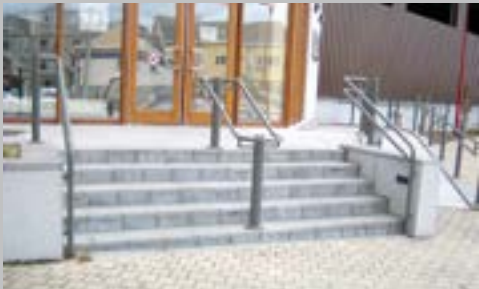
✓ Main-courante centrale si escalier large
