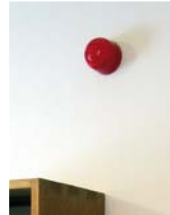
✓ Exemples d'une alarme incendie et de détecteurs de fumée avec flash lumineux
