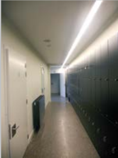
✓ Éclairage servant de ligne guide
